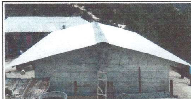
Foto 6: En la foto que se observa, que se ha sustituido la lámina del techo escolar.
