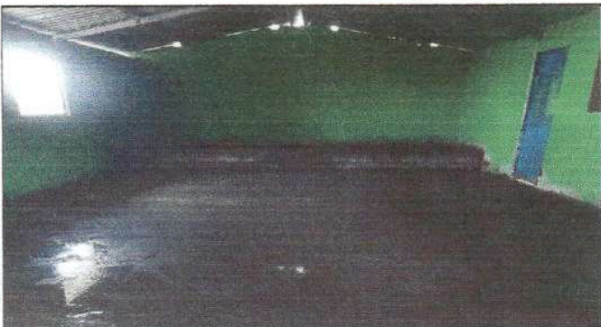
Foto 3: En la foto que se ha sustituido el piso de concreto de cemento líquido.
