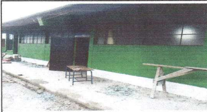
Foto 2: En la Foto que se observa que se han cambiado los vidrios en el centro educativo.
