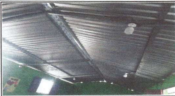
Foto 7: En la siguiente fotografía del establecimiento se muestra que se sustituyó el sistema eléctrico de las aulas del establecimiento.
