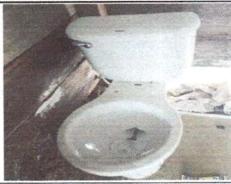
Foto 8: En la siguiente fotografía del establecimiento se sustituyó el inodoro
